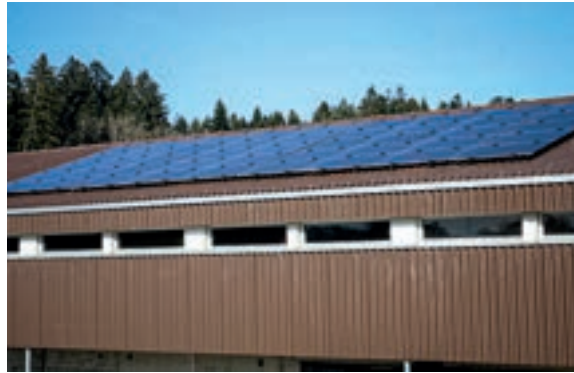
Auf dem Dach des Schützenhauses wurde neu eine Solaranlage installiert.
